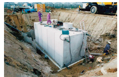
PC鋼より線による緊張 緊張作業後、目地部に止水加工を施します。
