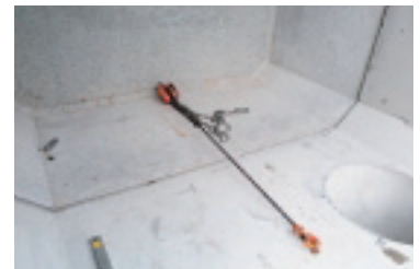
引き寄せ チェーンブロックによりブロック同士を引き寄せます。
