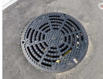
■北多久町多久原地内には次世代型 MH 蓋グレートタイプが採用
