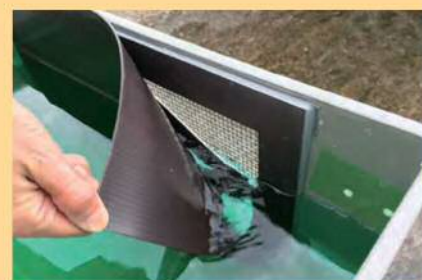
浸水時(止水シート取付)
