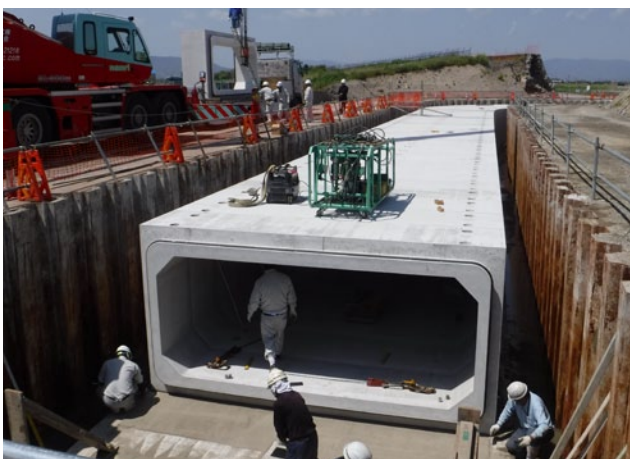
■製品据付状況
