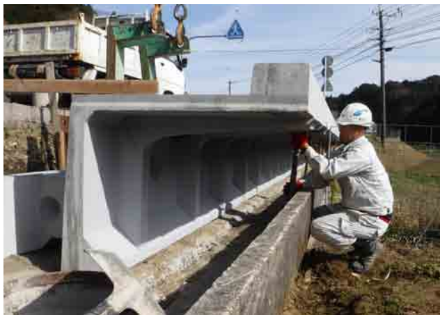
■現場打ちコンクリート前サポート
