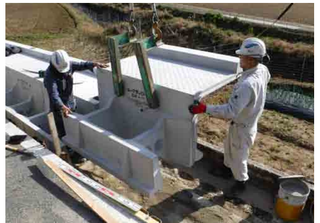
■製品布設状況
