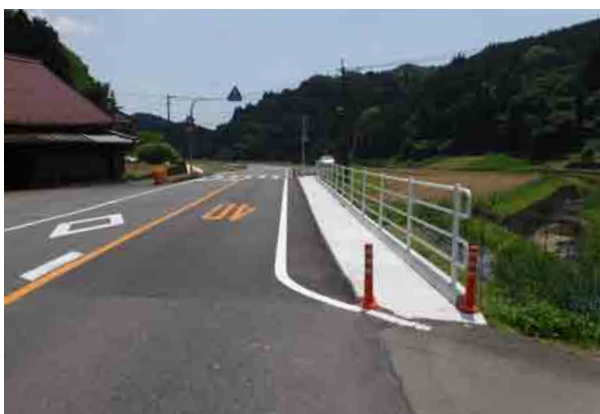
■着工後（※車道幅は変わらず、安全に通行できる歩道が完成）
