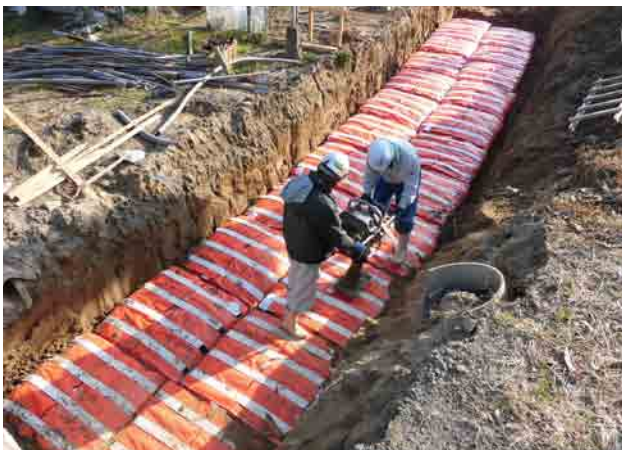
■外圧振動 (強制加圧) 袋の中の砕石が締め固められ強固な支持を得る
