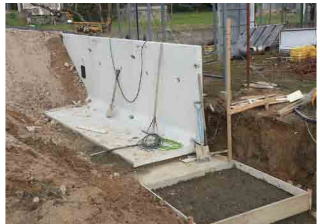
■L型擁壁設置
