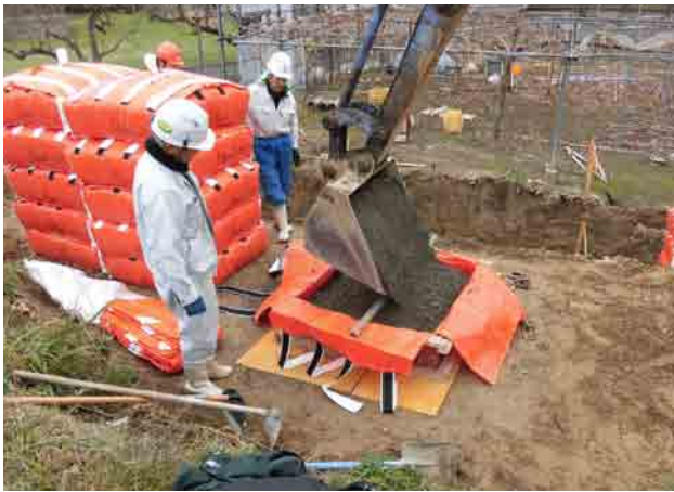
■クラッシャーラン投入 (現地発生土の有効利用も可能)
