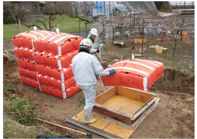
■脱枠・吊上げ
