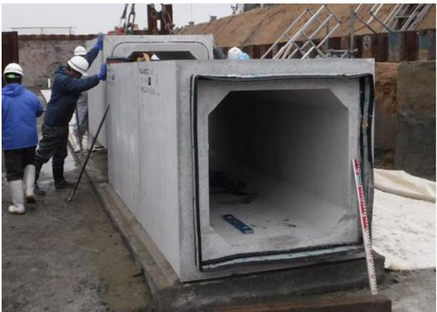
■新設現場打ちとの接続部（止水ゴム製品一体成型）
