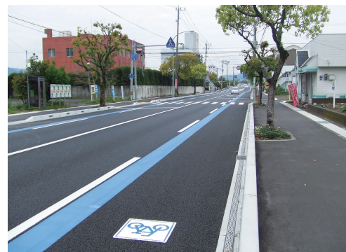
自転車専用レーン施工例
