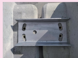
200×80 HDZ55をM20ボルトにて固定
