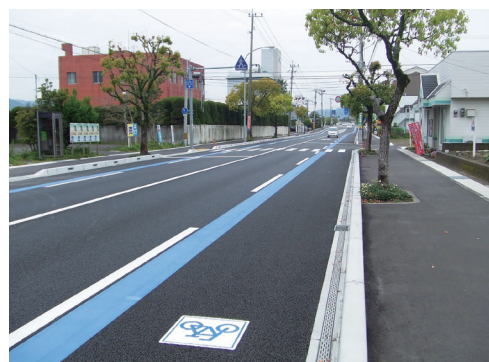
自転車専用レーン施工例
