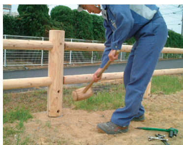
柱根元部のボルトを外し柱を両サイドにスライドさせます。
