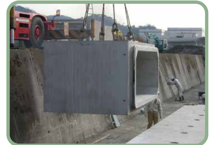
施工主：米原市 工事名：米原南第1雨水幹線整備工事 サイズ：3000×1200(幅×高さ)
