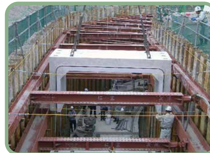
施工主：国土交通省浪速国道事務所 工事名：第二京阪（大阪北道路）讃良地区 下部その他工事 サイズ：3400×3000(幅×高さ)
