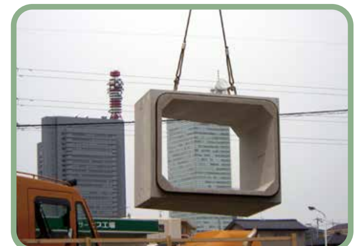
施工主：さいたま市 工事名：芝川右岸第1排水区下水道工事 サイズ：2000×1500(幅×高さ)
