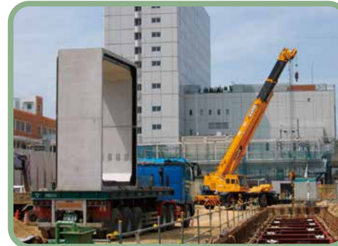
施工主：豊橋市 工事名：管渠施設改良工事 サイズ：3500×4000(幅×高さ)
