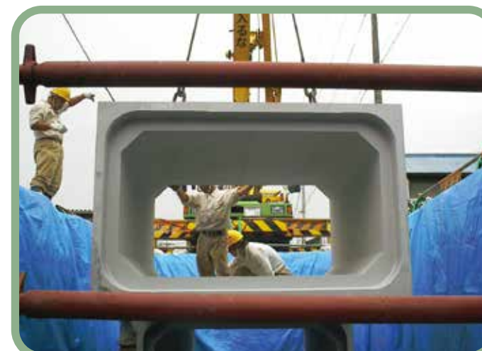
施工主：埼玉県児玉町役場 工事名：雨水管渠築造工事(その1) サイズ：1800×1000(幅×高さ)
