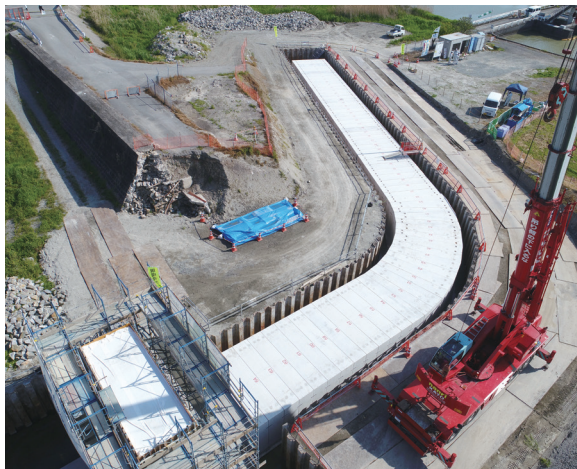
樋管での使用
