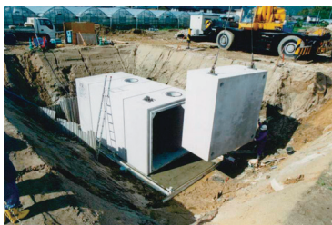
aブロック据付け これでブロック据付けは完了です。
