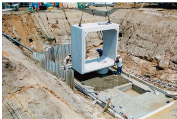
cブロック据付け ピット部の基礎にはモルタルを充填します。
