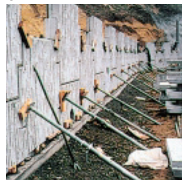
③スキン組立て・水平目地材の設置
