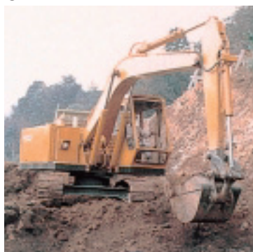
①掘削・整地
