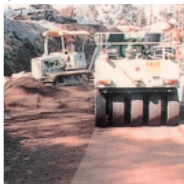
⑤盛土材のまき出し・締固め
