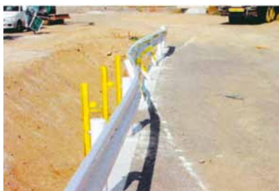
衝突後の状況 (直接基礎上)
