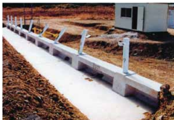
衝突後の状況 (補強土壁上)
