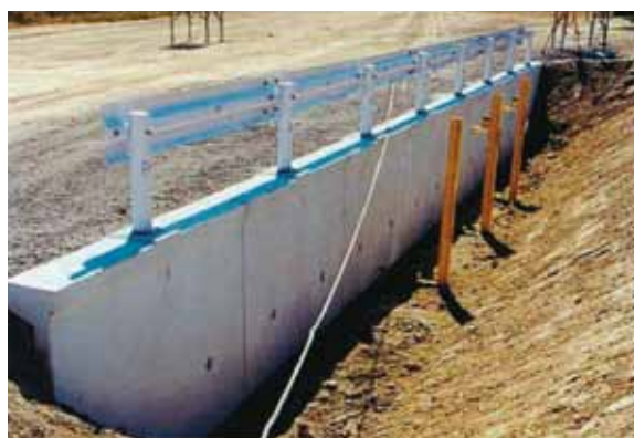
衝突実験前 (直接基礎上)
