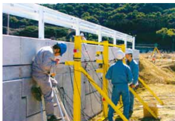
衝突実験前 (補強土壁上)
