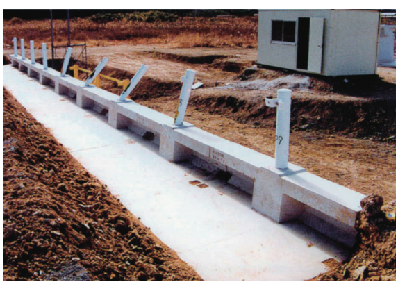
衝突後の状況 (補強土壁上)
