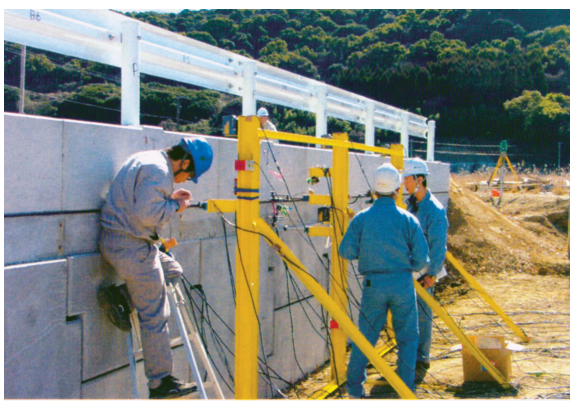
衝突実験前 (補強土壁上)
