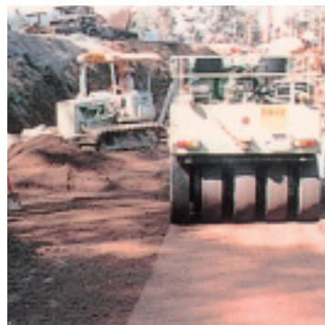
⑤盛土材のまき出し・締め
