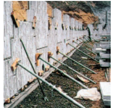
③スキン組立て・水平目地材の設置
