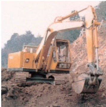
①掘削・整地
