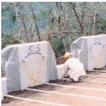
④透水防砂材の設置 ストリップの敷設
