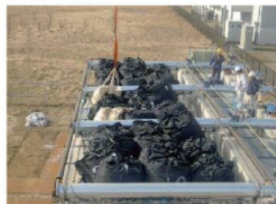
大型土囊载荷実験
